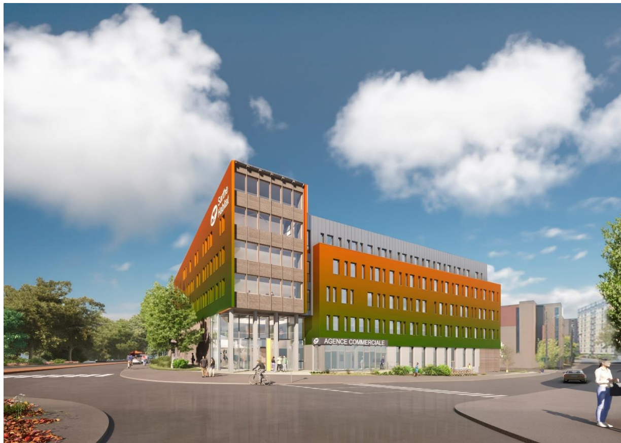
Crédit photo : @PHARO architectes et urbanistes
