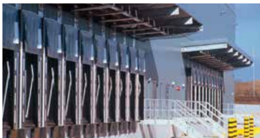
ASDA – Plateforme logistique de 110 000 m 2 de produits de la grande distribution – Projet réalisé pour le développeur Gazeley – Lutterworth (Royaume-Uni) – Architecte : CHESTWOOD Associates
