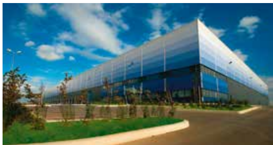
MAGNA PARK ARRAS – Parc logistique de 36 000 m 2 occupé entre autres par la coopérative UNEAL, qui approvisionne les magasins GAMB VERT – Projet réalisé pour le développeur Gazeley – Arras (59) – Architecte : SAGL
