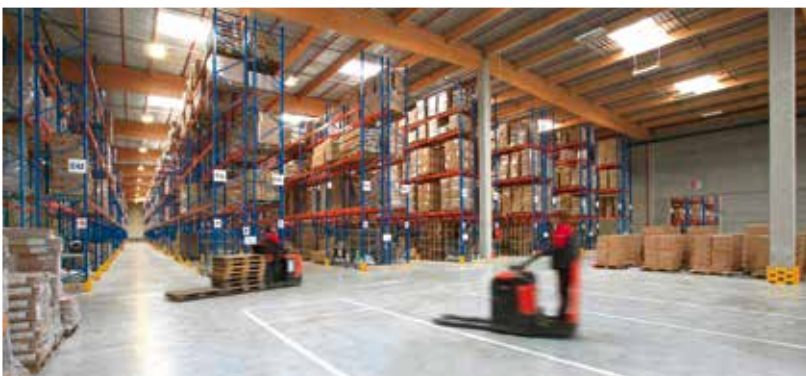
ID LOGISTICS – Plateforme logistique de 74 600 m 2 dédiée à l'enseigne ALINÉA – Brebières (62) – Architecte : AGECCA FAIRHURSTS
