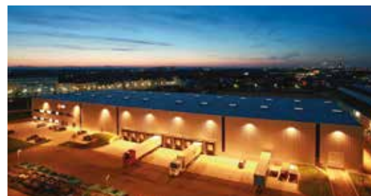
UTI – Plateforme d'éclatement et d'assemblage multi-produits de 7 500 m 2 – Projet réalisé pour le développeur Gazeley – Mannheim (Allemagne) – Architecte : Michel WITZ
