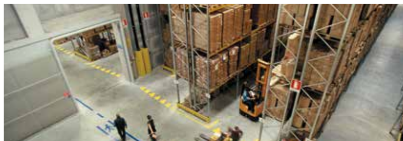
PARC SOMAGLIA – Parc logistique de 3 bâtiments dont 2 embranchés fer d'une surface totale de 101 050 m 2 exploité par TNT pour la distribution régionale de produits de grande consommation et de jouets – Projet réalisé pour le développeur ProLogis – Somaglia (Italie) – Architecte : JACOBS Italia Spa
